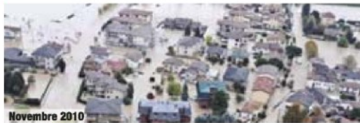
Novembre 2010 Una vista dell'esondazione del fiume Bacchiglione a Cresole di Caldogeno (Vc) (Ansa)
